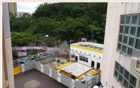
由於課室不夠，需拆燒烤場，擴建新翼課室
